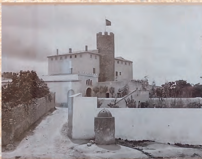
El castell i el pou del comú pels volts de l'any 1911. Les obres de restauració del castell ja estan finalitzades. Foto: cedida pels propietaris actuals del castell.
