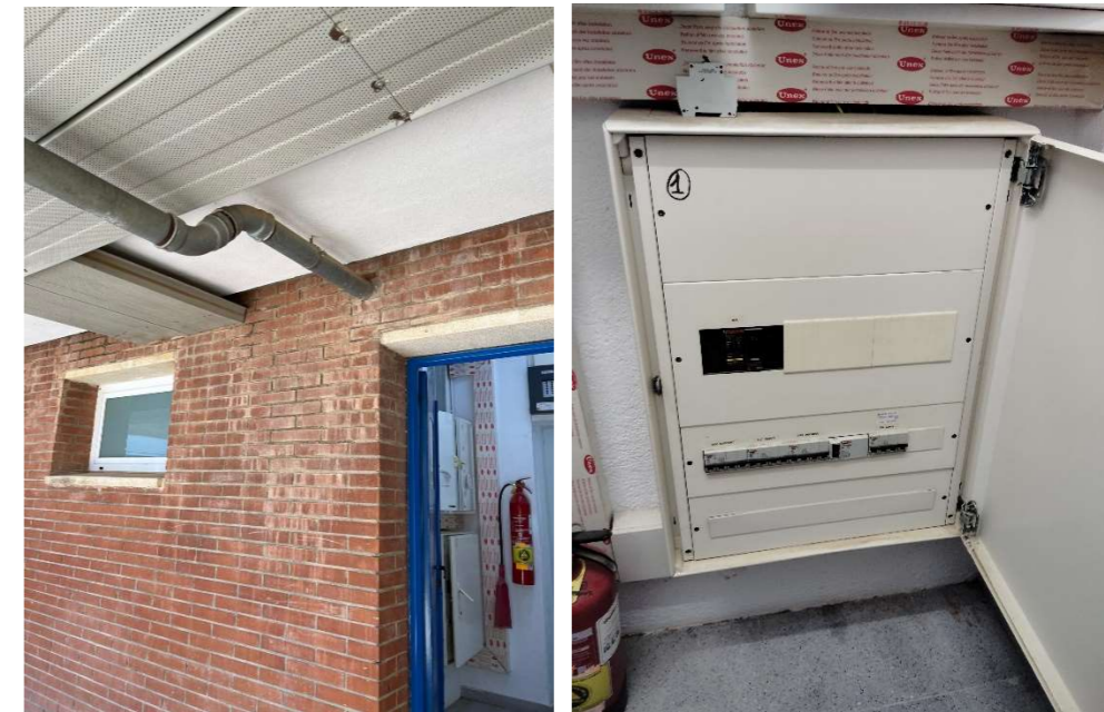
Figura 6 Safata que connecta al QGBT
