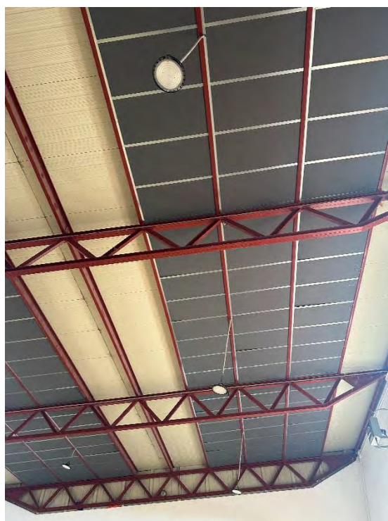
Sostre Gimnàs (Edifici 1)
