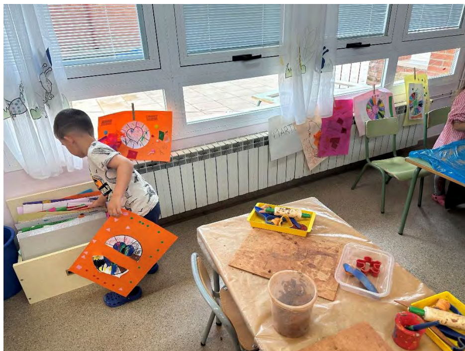
Detall radiador. Edifici 4 (Educació Infantil 5&6)
