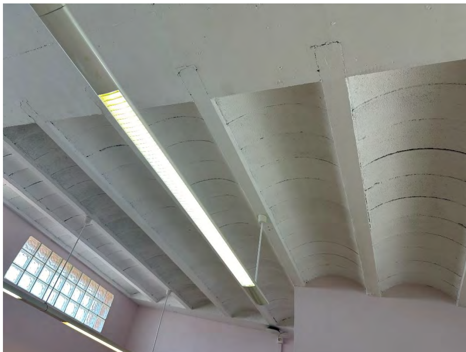
Sostre interior Edifici 4 (Educació Infantil 5&6).
